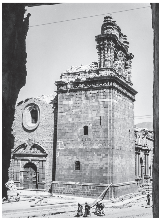
Figura 1. Una ciudad en ruinas. Destrucción causada por el terremoto en la iglesia de Santo Domingo. Colección Alberto Giesecke.
