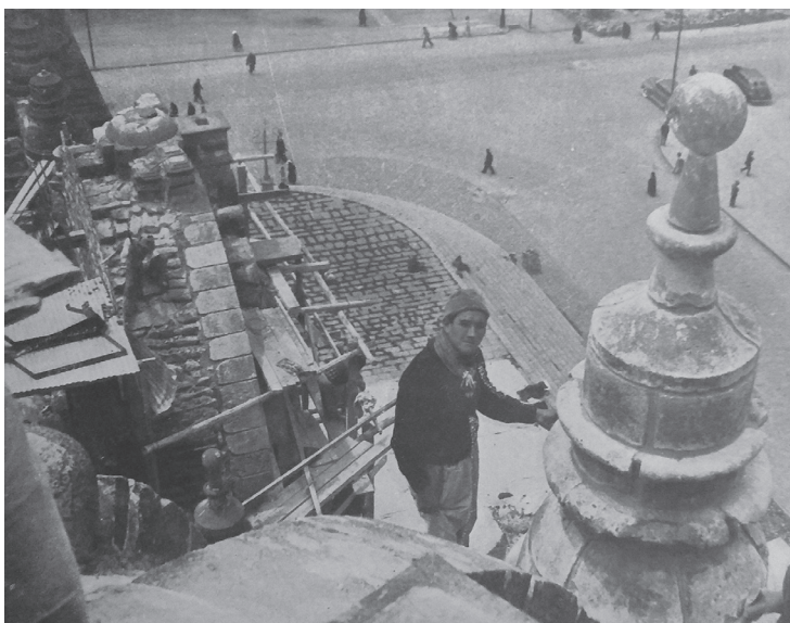
Figura 2. Operarios durante la restauración de la catedral del Cusco.
